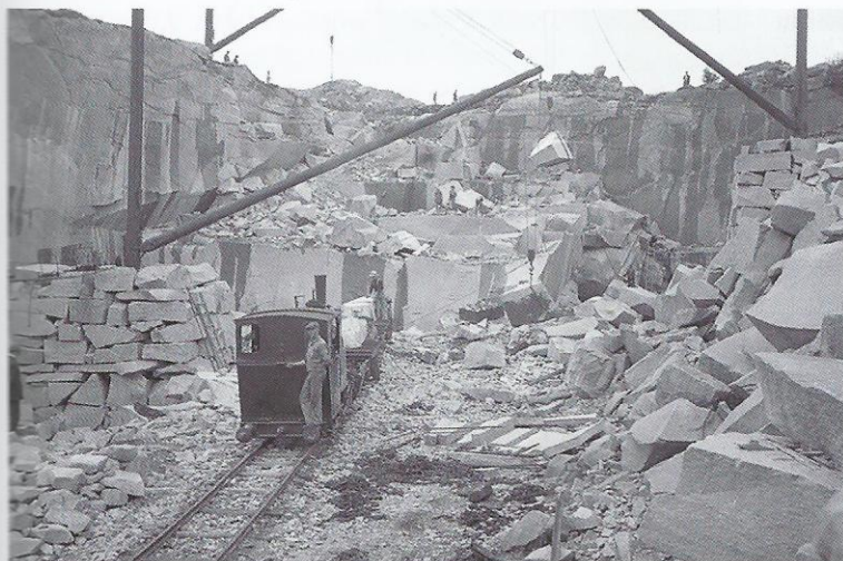
Med hjälp av maskkranar lastas granitblock på flakvagnar dragna av Hanomag 4922/1907. Foto år 1929, förmodligen i Stallebrottet: David Almqvist (Samling: Jan Ericson)
